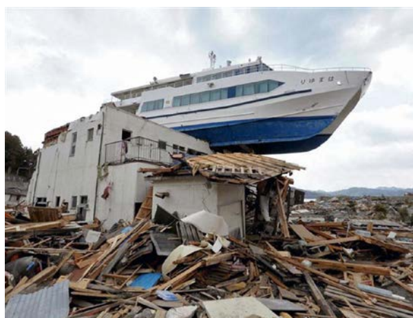
東日本大震災の津波で岩手県大槌町の民宿の屋上に乗り上げた観光船「はまゆり」 (WEB サイト：産経フォットより引用)
